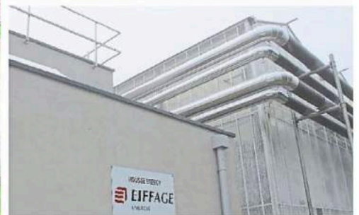
Le moteur de la centrale fonctionne 24 heures sur 24, pendant cinq mois. La récupération des calories dégagées par les fumées et le moteur du groupe électrogène permet de chauffer l'eau d'un ballon d'eau chaude, qui alimente le circuit de chauffage des serres. Les grosses conduites qui sortent de la centrale approvisionnent les serres en gaz carbonique.
